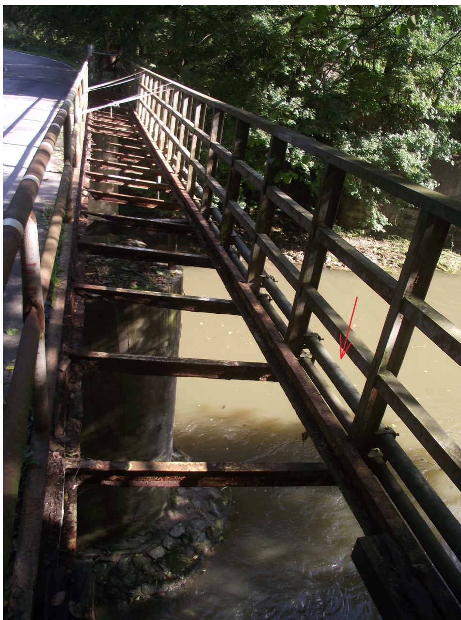
Pohled na chráničky el. přípojek čerpací stanice VAS (SO401) a sdružení chatařů (SO402) na stávající mostní konstrukci.
