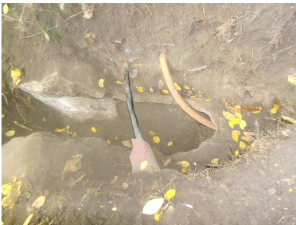
Detail obnažené části el. přípojky sdružení chatařů (SO402) na začátku úseku
