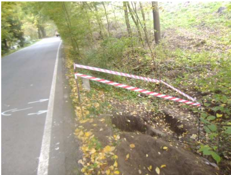
Pohled na obnaženou část el. přípojky sdružení chatařů (SO402) na začátku úseku
